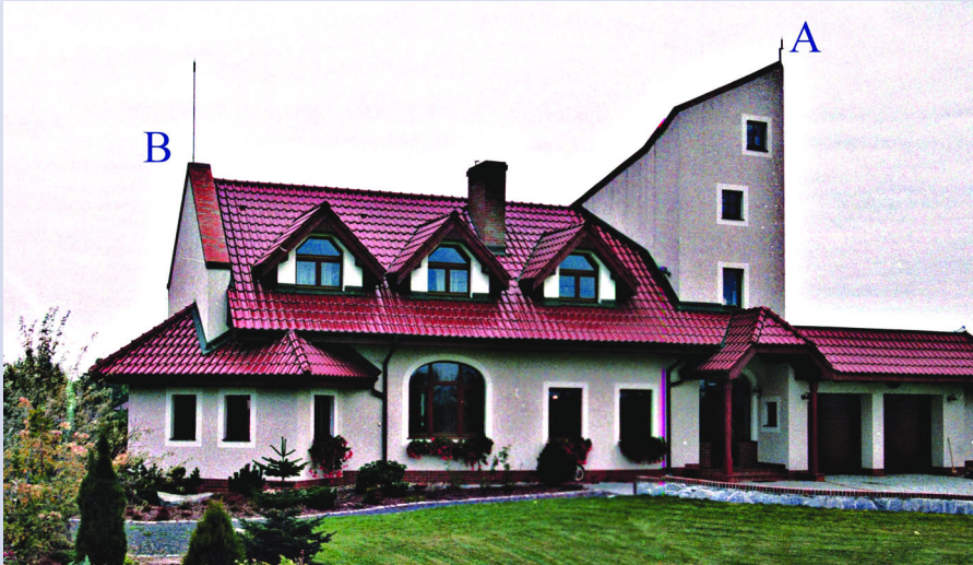
Bild 6. Einschlag in ein Einfamilienhaus in Kamieniec Wroclawski (Steine)/Polen (ESE-Fangstange in A mit einer Höhe von 13 m; Einschlag in B in 18 m Entfernung; danach erfolgte die zusätzliche Installation einer ESE-Fangstange mit 3 m Höhe in B)
